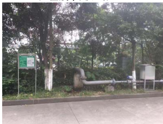
厂区废水总排口
