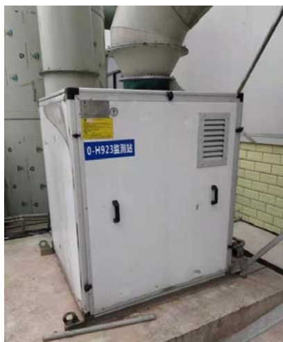
挤出废气引风机房
