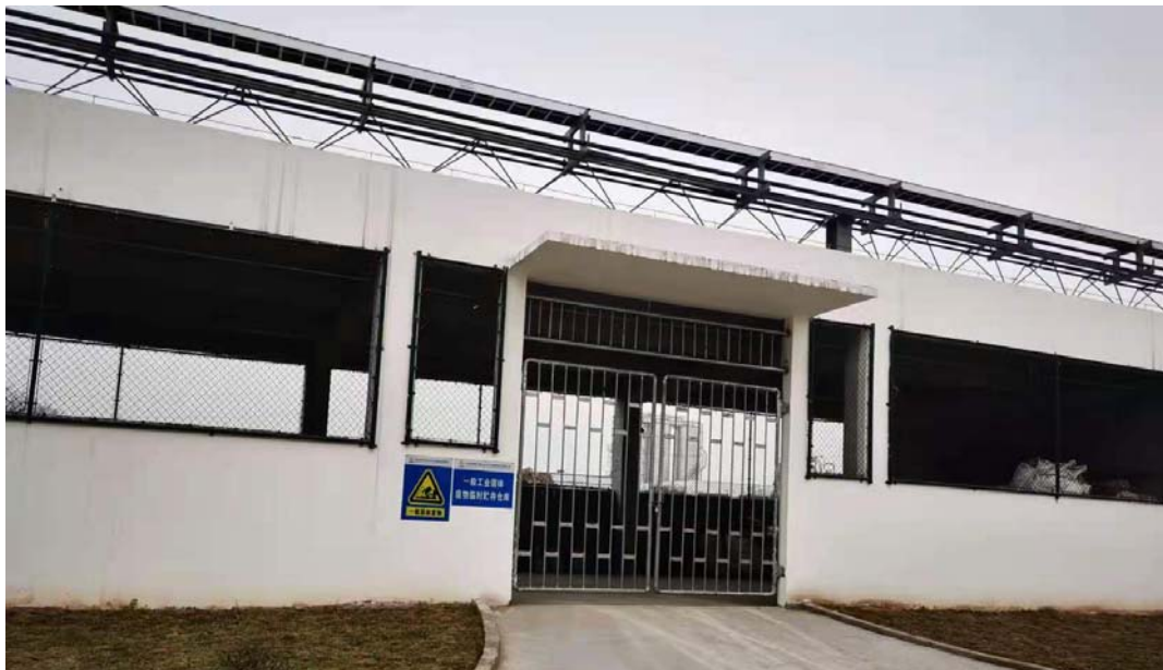
新建一般工业固废间
