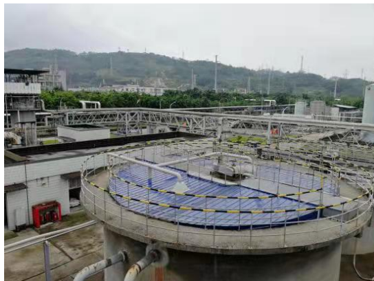
厂区废水处理站
