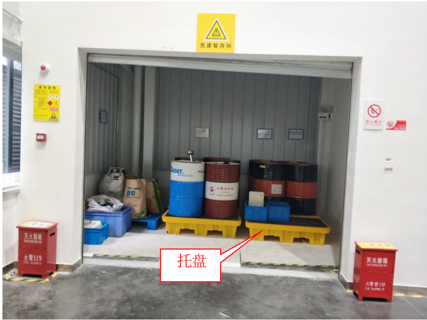
危废暂存间、标识牌、灭火器
